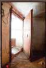
Entrada sud. Porta d'accés, detall interior.
