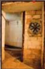
Entrada sud. Detalls del sistema de ventilació per al correu de xampinyons.
