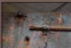
Entrada nord, porta exterior. Bollons.
