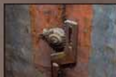
Entrada nord, porta exterior. Mecanisme de tancament hermetic.
