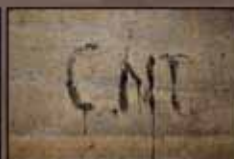
Entrada nord, paret del damer de la porta exterior. Pintada de la CNT, probablement original.
