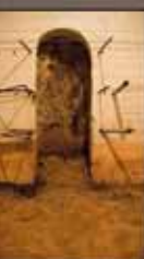
Galeria sud. Inici d'un tram de galeria macaboda.
