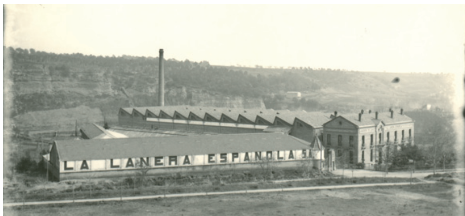
La Lanera Española, fàbrica construïda entre els anys 1915-1917, en una terrassa superior del Ripoll, a tocar la carretera de Castellar del Vallès. Anys 1920. La xemeneia, i també bona part de la fàbrica, encara es conserven.
