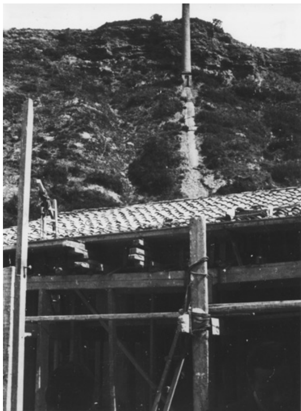
Xemeneia del molí de l'Amat. S'hi observa clarament el traçat del fumeral excavat al llarg del talús. 1942. Arnau Izard / AFUES
